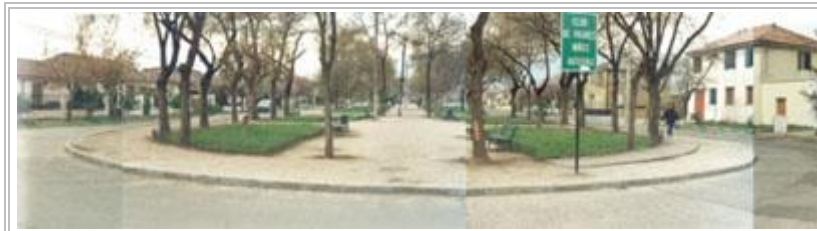
Fig. 10. Paseo Plaza Central, proyecto de Karl Brunner en Plano Oficial de Urbanización de la Comuna de Santiago, 1939, "sector Independencia". Foto M.I.P. 2000.
