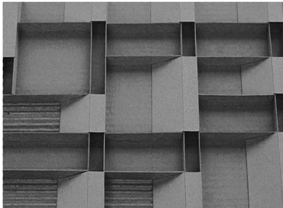
Mantenimiento del Sistema, cambio de Estructura.
