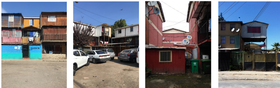
FIGURA 7. AMPLIACIONES IRREGULARES EN CONJUNTOS DE BLOCKS C. ELABORACIÓN PROPIA.
